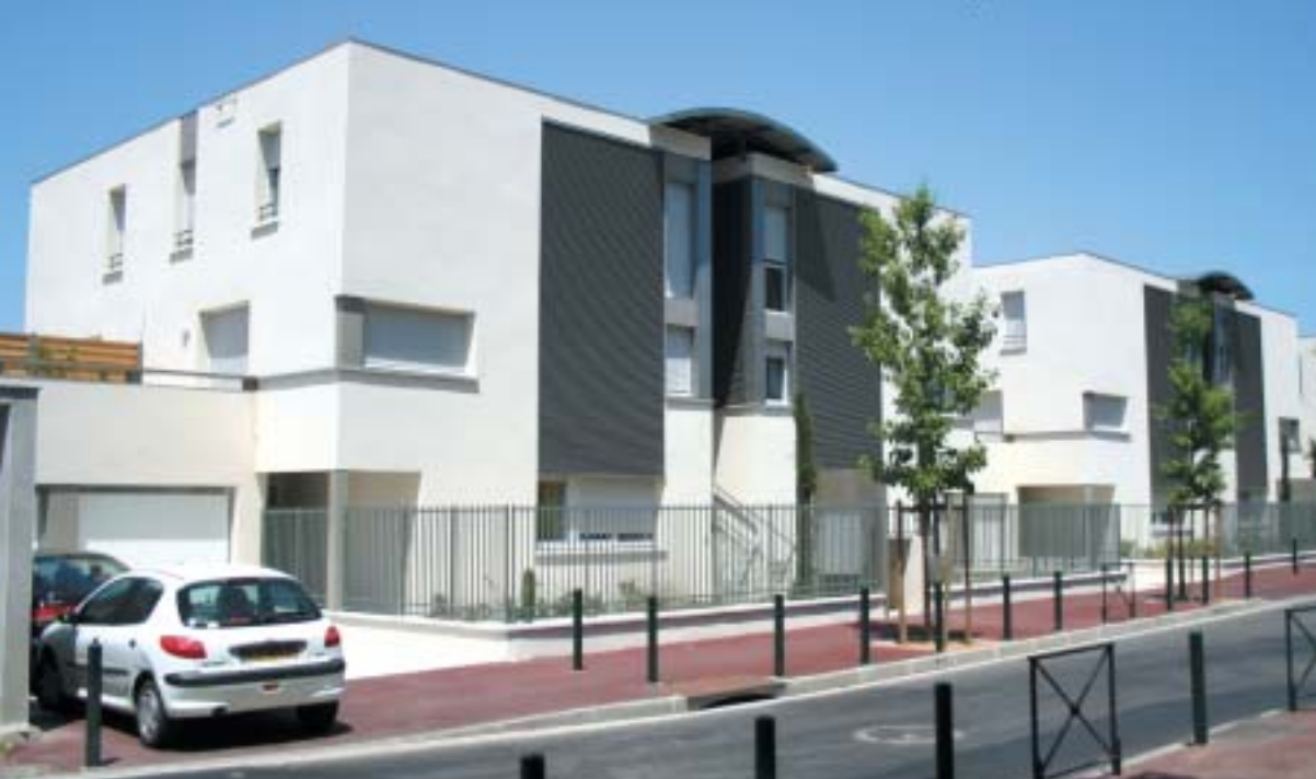
Construction de logements - La Faourette
